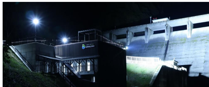
ライトアップ中の発電所(左)
